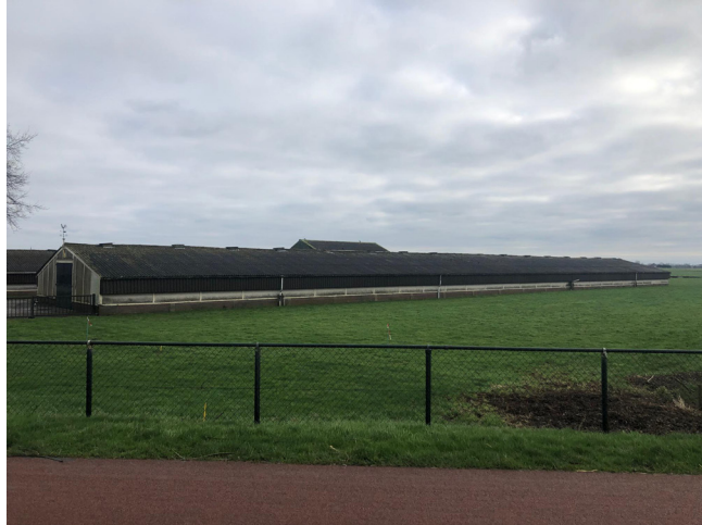
Foto zicht op de te verwijderen kippenschuur D, bron: foto OLY Advies
