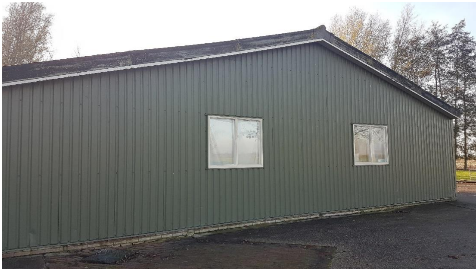
Afbeelding 6: Te slopen opslagschuur.
