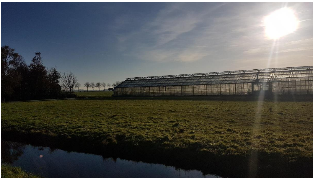
Afbeelding 2: De te slopen kweekkas aan Wipbruglaan 4.
