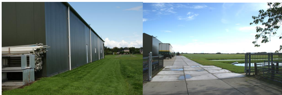
Uitbreidingslocaties oostzijde (links) en zuidzijde met spoelbassins (rechts) d.d. 18 september 2017.
