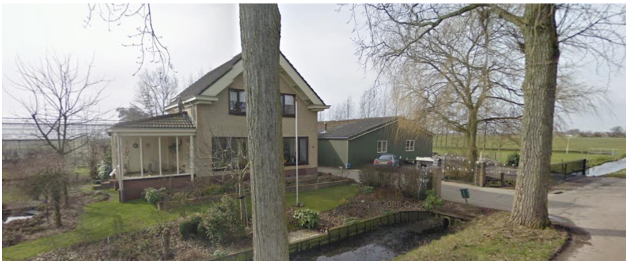
De te behouden bedrijfswoning voorzijde Wipbruglaan 4 te Spanbroek, bron foto: Google Streetview
